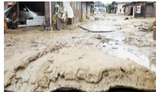
総合防災インフラ管理
